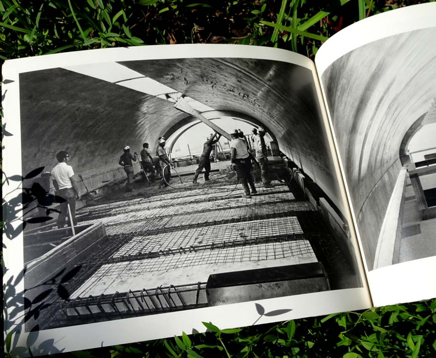
キンベル美術館のコンクリート工事の様子。キンベル美術館の屋根の形はサイクロイド曲線と 呼ばれるカマボコ型。天井面に見える光沢は、コンクリートの耐久性のパロメーターであるガ ラス質が緻密に形成されていることを示している。 「LIGHT IS THE THEME」 Kimbell Art Foundatin, Fort Worth, Texas 1975
