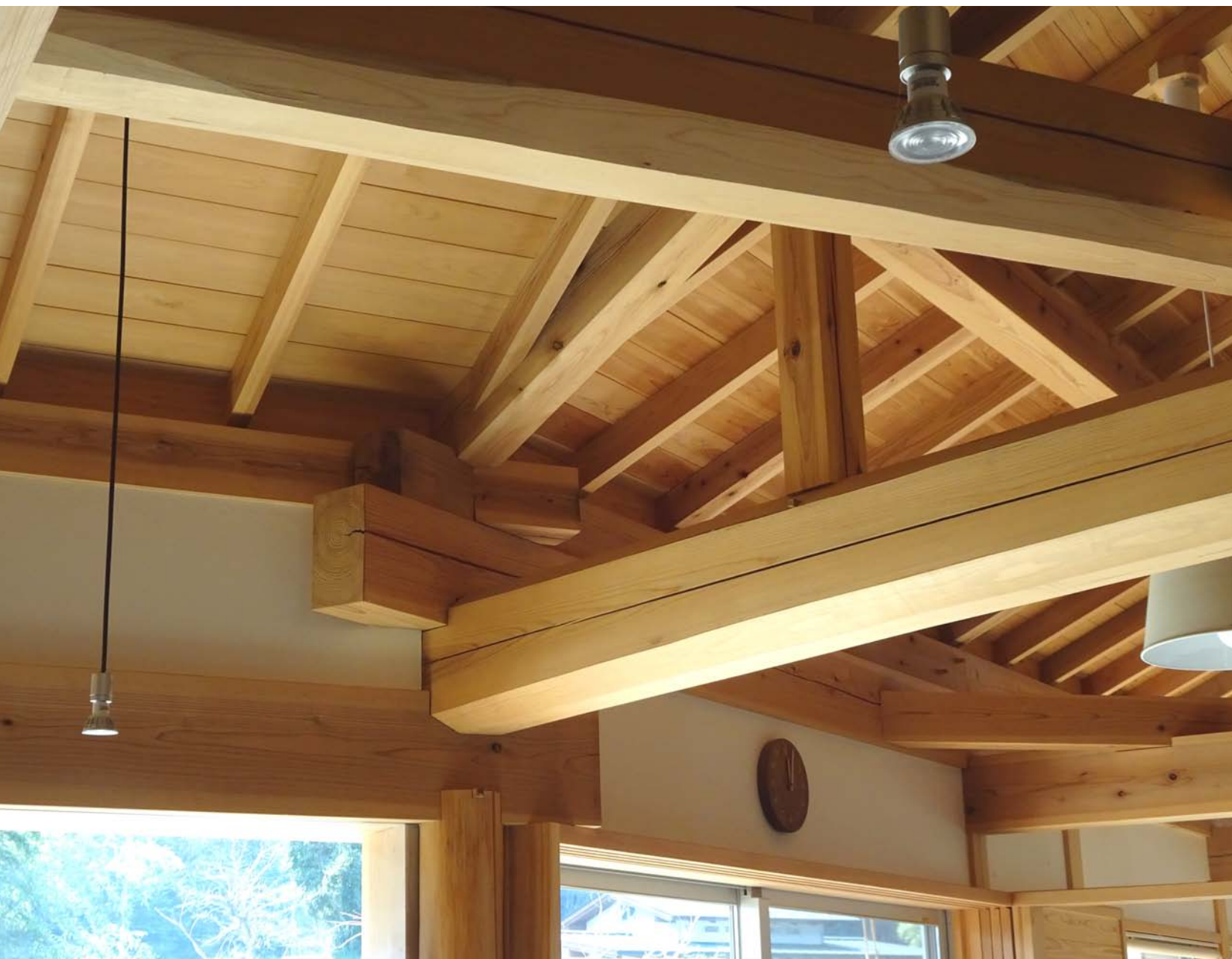
渡り あこ 腰構法でつくられた軸組み。鉛直荷重の伝達に安心感のある渡り腰構法は、「木にしたがう」構造システムを志向する。(埼玉県比企郡小川町)
