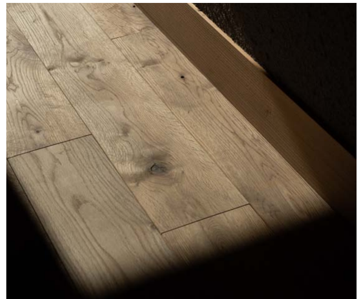
左：目板張りで張られたミズナラの外壁。上：外壁と同様、チップ用材として山から出てきた原木からつくられたミズナラのフローリング。（写真：日比野寛太）
