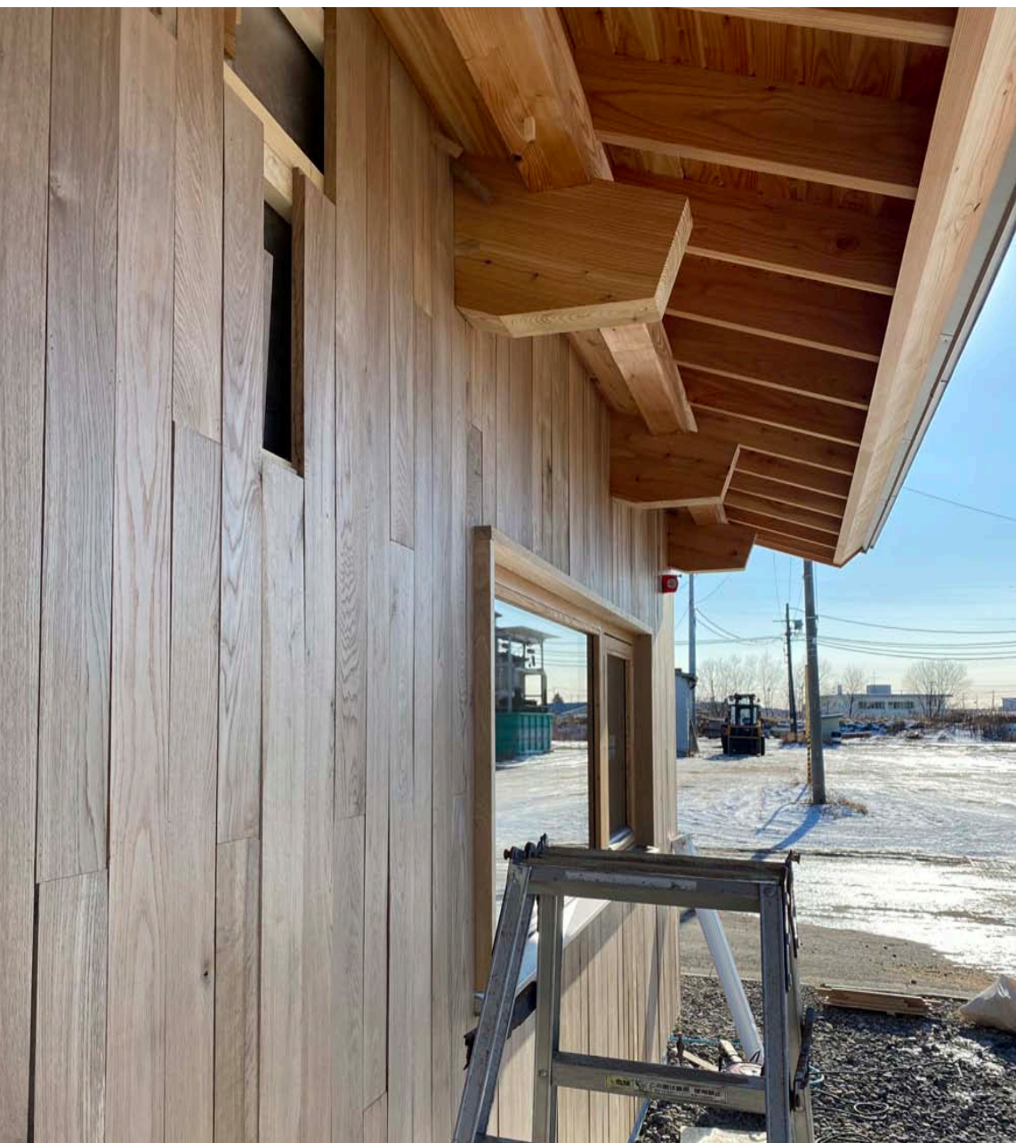
目板で押さえる前の羽目板を施工中の外壁。(写真：木村祥悟)
