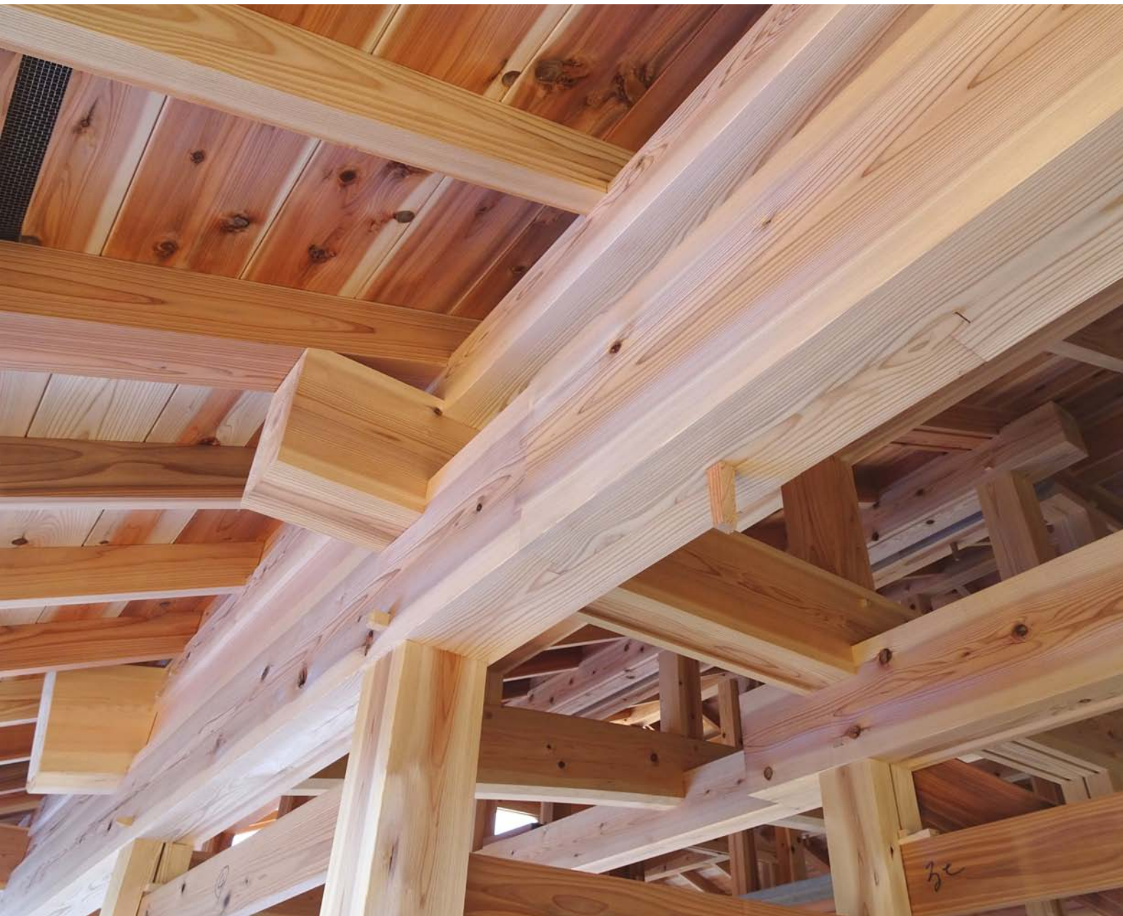
渡り腰構法で組まれた柱梁。屋根の水平力を軸組に伝えるために、母屋と軒桁の間には埋木が入れられる。(埼玉県鴻巣市)
